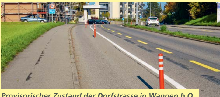
Provisorischer Zustand der Dorfstrasse in Wangen b.O.
